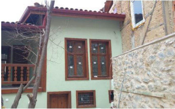
Şekil 31. Restorasyon sonrası güney yöndeki bahçe cephesinin görünümü
