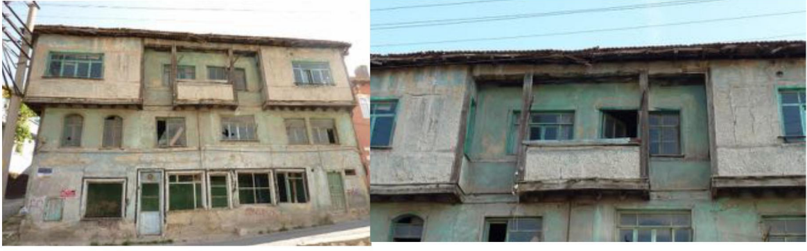
Şekil 18. a), b) Kuzey cephede biri balkona dönüştürülen çıkmaların görünümü ve kapatılan pencerelerin izleri.
