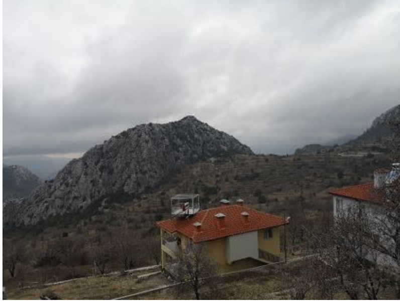
Şekil 8. Güzelsu yerleşiminde dokuyla uyumsuz yeni yapılar (2020)
