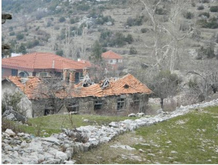
Şekil 9. Güzelsu geleneksel yerleşiminde terk edilmiş geleneksel yapı ve arkasında çağdaş malzeme kullanılarak inşa edilmiş yeni yapı örneği (2020)
