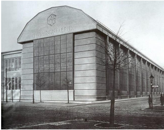
Şekil 2. AEG Türbin Fabrikası (Anonim 1)
