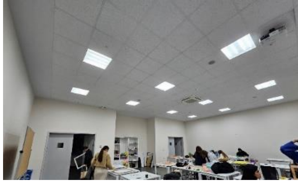
Şekil 2. Bodrum katta bulunan BB-34 numaralı stüdyo aydınlatma elemanları görünümü
