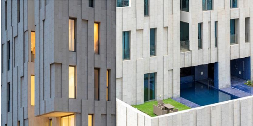
Granit Cephe Detay ve Havuz
