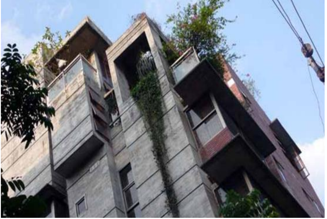
Güney Batı Görünüş, Üst Katlar
