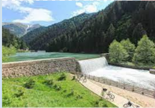
Şekil 13 Uzungöl girişinde yapılan rüsubat bendi
