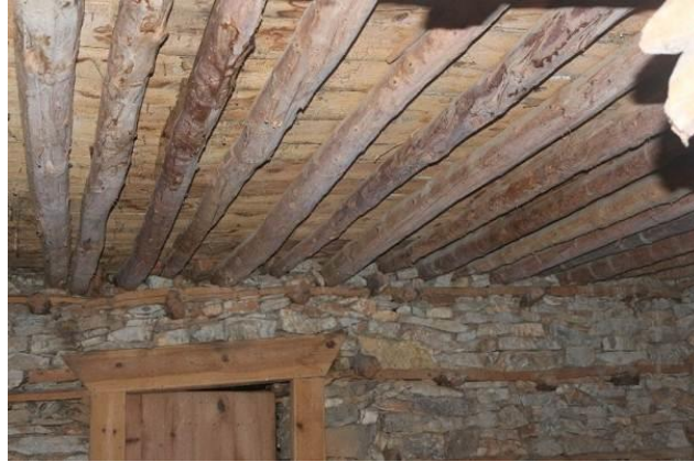
Resim 10/ Photo 10: Tavanda yer alan ahşap kirişlemeler / Wooden beams on the ceiling (Kuleli, Akdeğirmen, 2019).
