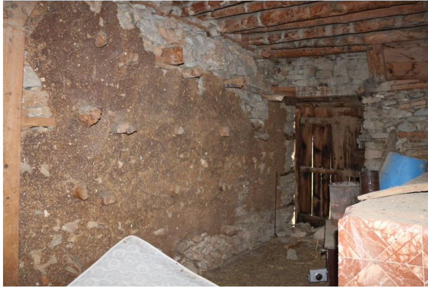
Resim 8/ Photo 8: 'Ahıraltı' ya da 'evöğün' olarak (ZK01) adlandırılan mekan / The space which is called 'ahıraltı' or 'evöğün' (GF01) (Kuleli, Akdeğirmen, 2019).
