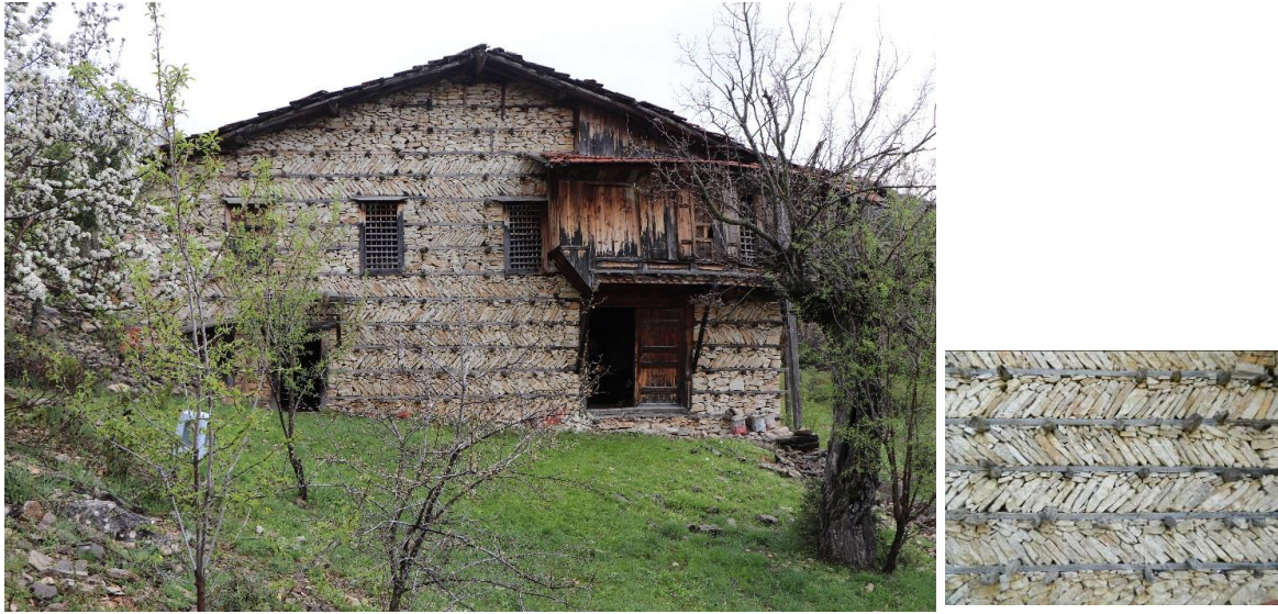
Resim 7a, b / Photo 7a, b: Yapının kuzey (giriş) cephesi ve duvar örgü detayı / The North (entrance) elevation of the building and wall construction detail (Kuleli, Akdeğirmen, 2019).
