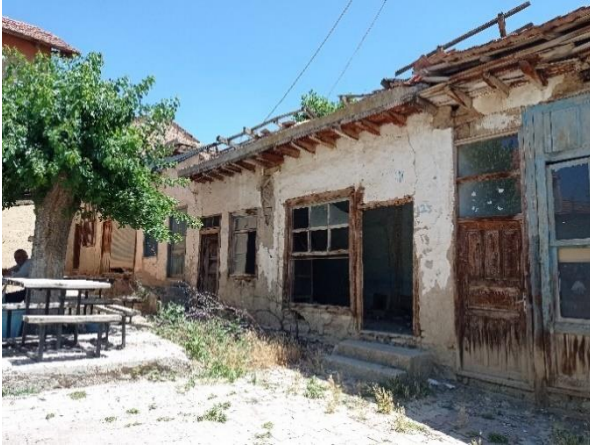
Şekil 8. 180/13 parseldeki dükkân sırası
