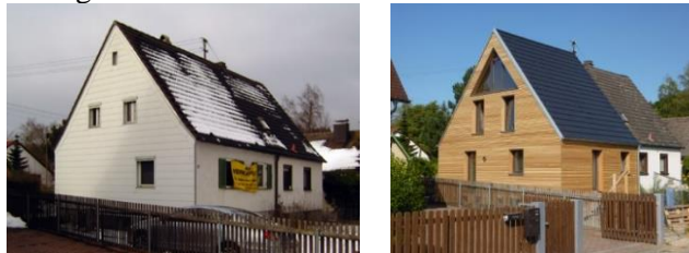
Figure 11: Old and New Facade Views of B-8, Bayern / Germany (Holzbau Deutschland Leistungspartner, 2008).
