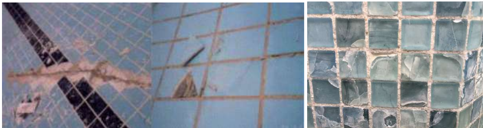
Şekil 2. A) Karo Kaplamalarında Görülen Çatlama ve Dökülmeler (Wan, 2004); B) Cam Mozaik Kaplamada Meydana Gelen Çatlama, Kırılma ve Malzeme Dökülmeleri (Anonim, 2016)
