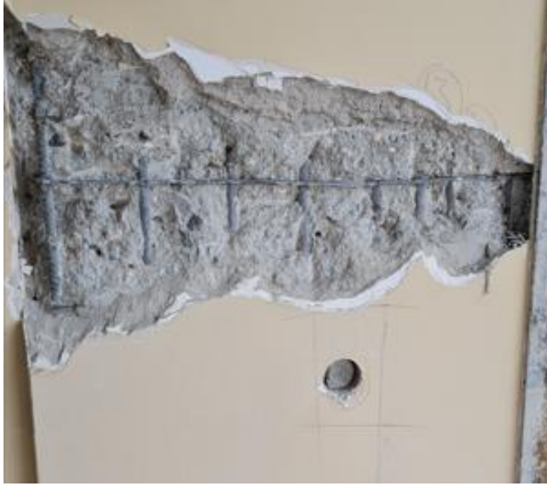
Şekil 4.14. Mevcut Yapı Düşey Elemanlarında Yapılan Karot ve Sıyırma a) Kolon b) Perde
